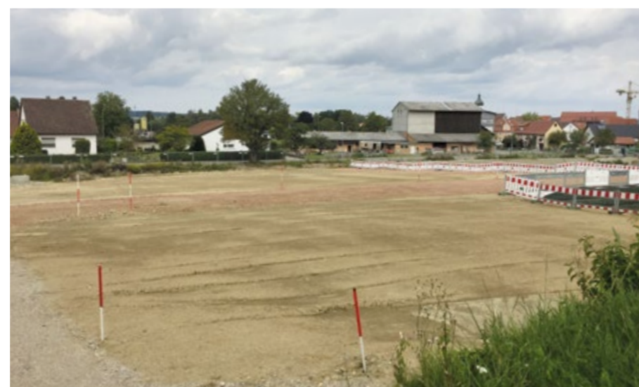
Hier entsteht die „Alte Ziegelei“
