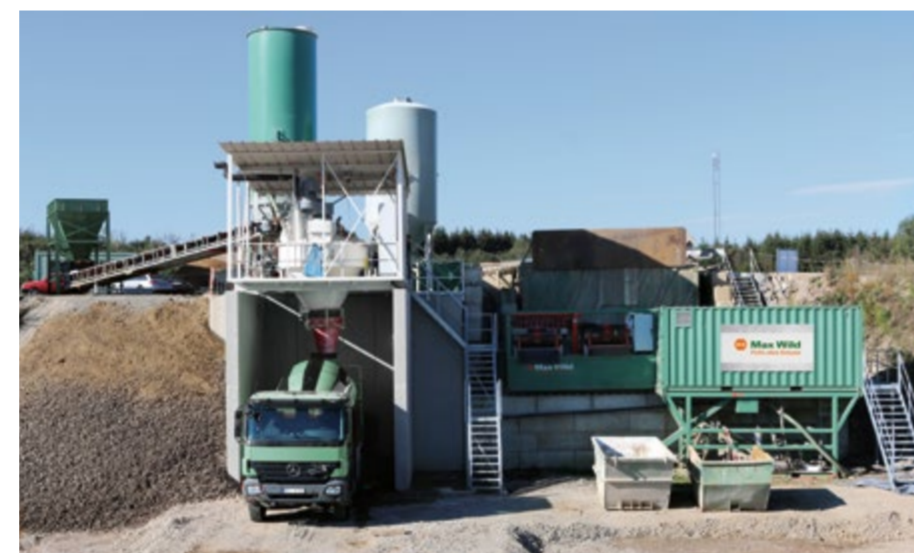
Recyclinganlage im Entsorgungszentrum Eichenberg
