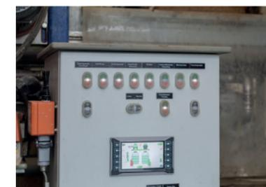
Vollautomatische Steuerung mit integriertem Display
