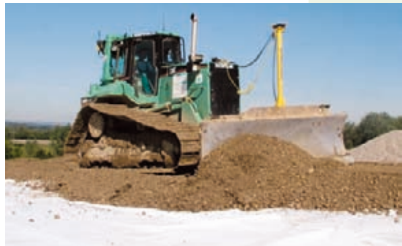
GPS-gesteuerte Raupe im Einsatz
