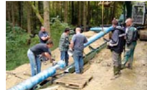
Luxemburg: Einzug einer 600 Meter langen duktilen Gussleitung (DN 250)
