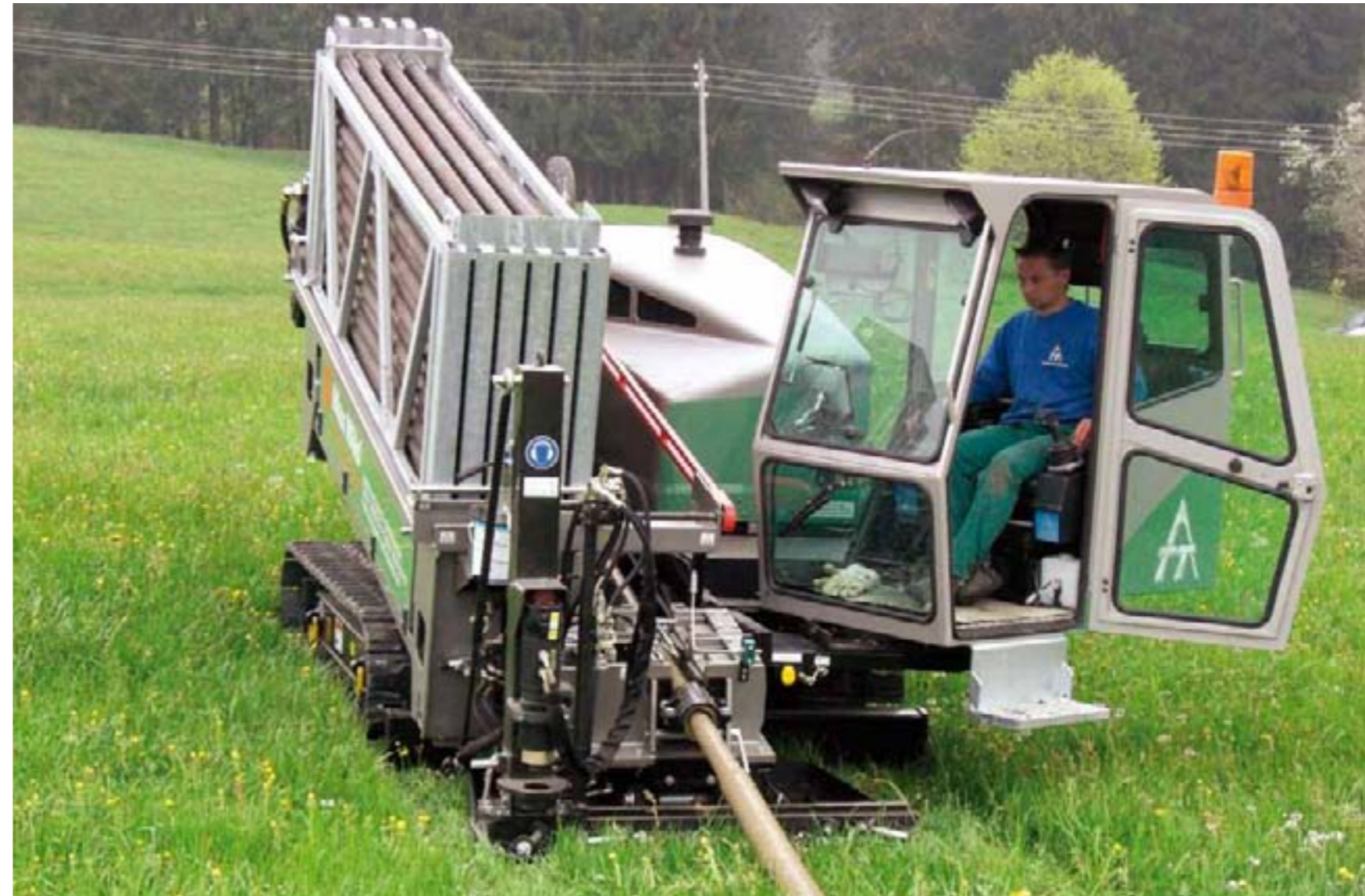
15-Tonnen-Bohrgerät im Einsatz auf Baustellen im Allgäu
