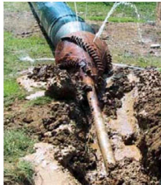
Aufweitkopf für den Einzug eines PE-HD-Rohres DA 315
