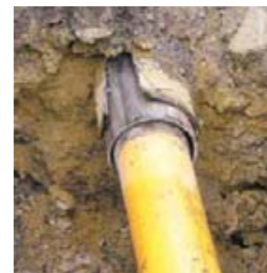
80-Tonnen-Berstanlage beim Rückzug und Rohreinzug eines Stahlrohres DN 125
