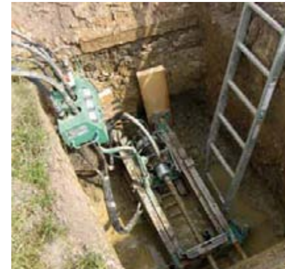
Grubenanlage in der dafür notwendigen Baugrube
