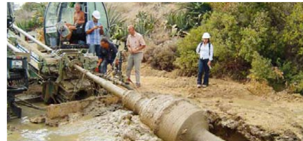
Portugal: Drei Bohrungen für eine Abwasserdruckleitung mit Längen bis 620 Meter (DA 560) in der Algarve
