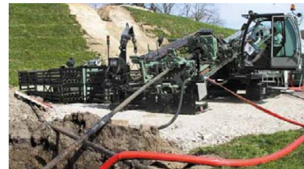
Kempten: Querung der Iller mit einer 320 Meter langen PE-HD-Leitung (DA 355) in Fels
