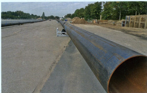
Die Rohrstränge auf dem Baugelände
