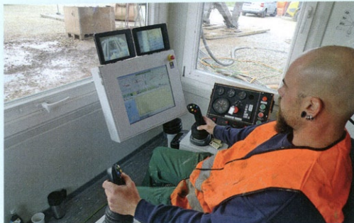
Steuerstand der Bohranlage MW 1125/45
