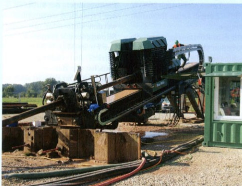
Rigsite mit Bohranlage und Bohrequipment
